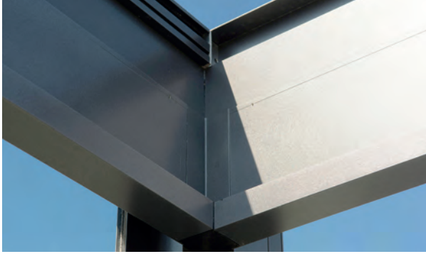
Wasserablauf in der Stütze
